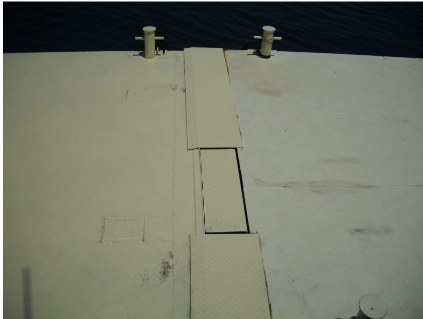
Photo. 2.42 ポンツーンの接合部の隙間に設置したカバー (カバーが設置されたおかげで安全性が向上した)
