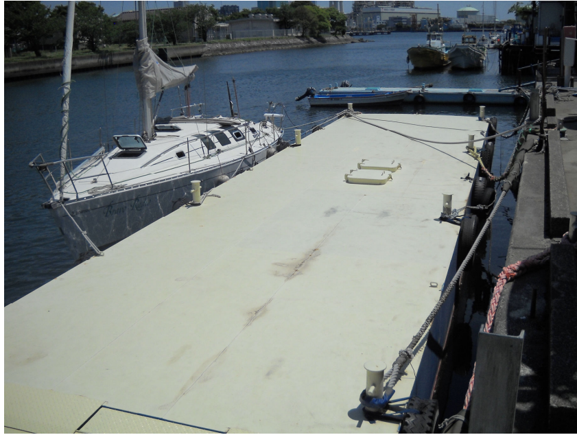
Photo. 2.38 岸壁に平衡に設置された台船式ポンツーン（浮き栈橋） （ポンツーンに係留するクラブ艇）
