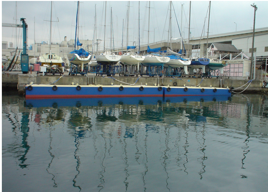
Photo. 2.37 岸壁に平衡に設置された台船式ポンツーン（浮き栈橋） （4 m x 2 5 m x 1 mの鋼鉄製、岸壁からロープとチェーンで係留）
