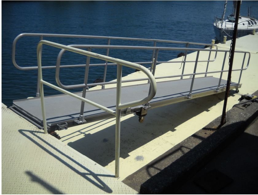
Photo. 2.41 ポンツーンへの乗り降りのため設置されたスロープ (スロープが設置されたおかげで安全性が向上した)
